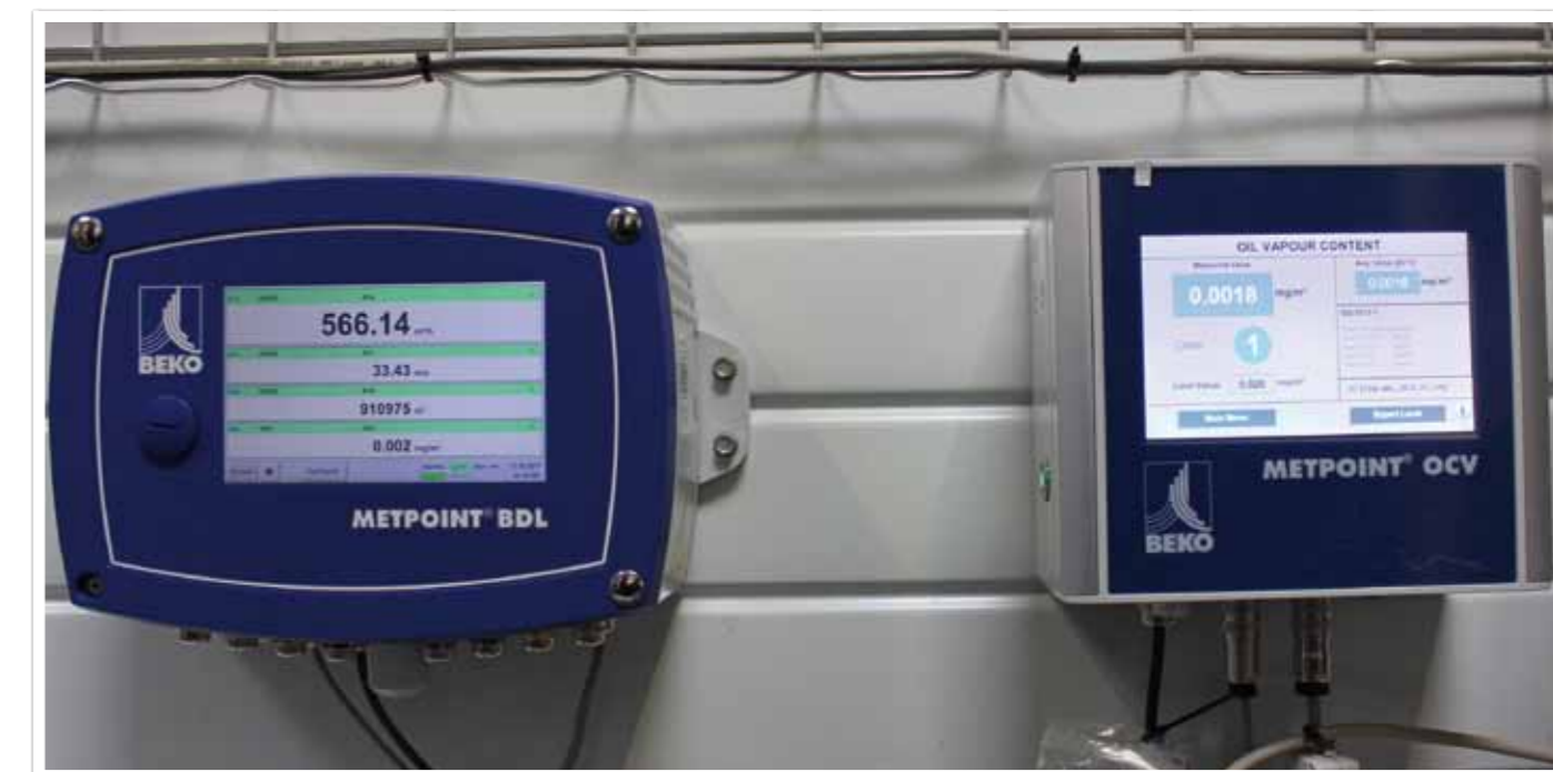
Le terminal METPOINT® BDL permet d'enregistrer le débit, la pression, le ratio Wh/m 3 , le PRSP et la teneur résiduelle en huile, etc., de les afficher et de les communiquer via un réseau Ethernet. Quant à l'analyseur de la présence d'huile résiduelle METPOINT® OCV, il affiche des valeurs qui ont permis au client d'avoir la certitude de disposer d'un air comprimé de haute qualité pour son process, de classe 1 en huile selon ISO 8573-1.
