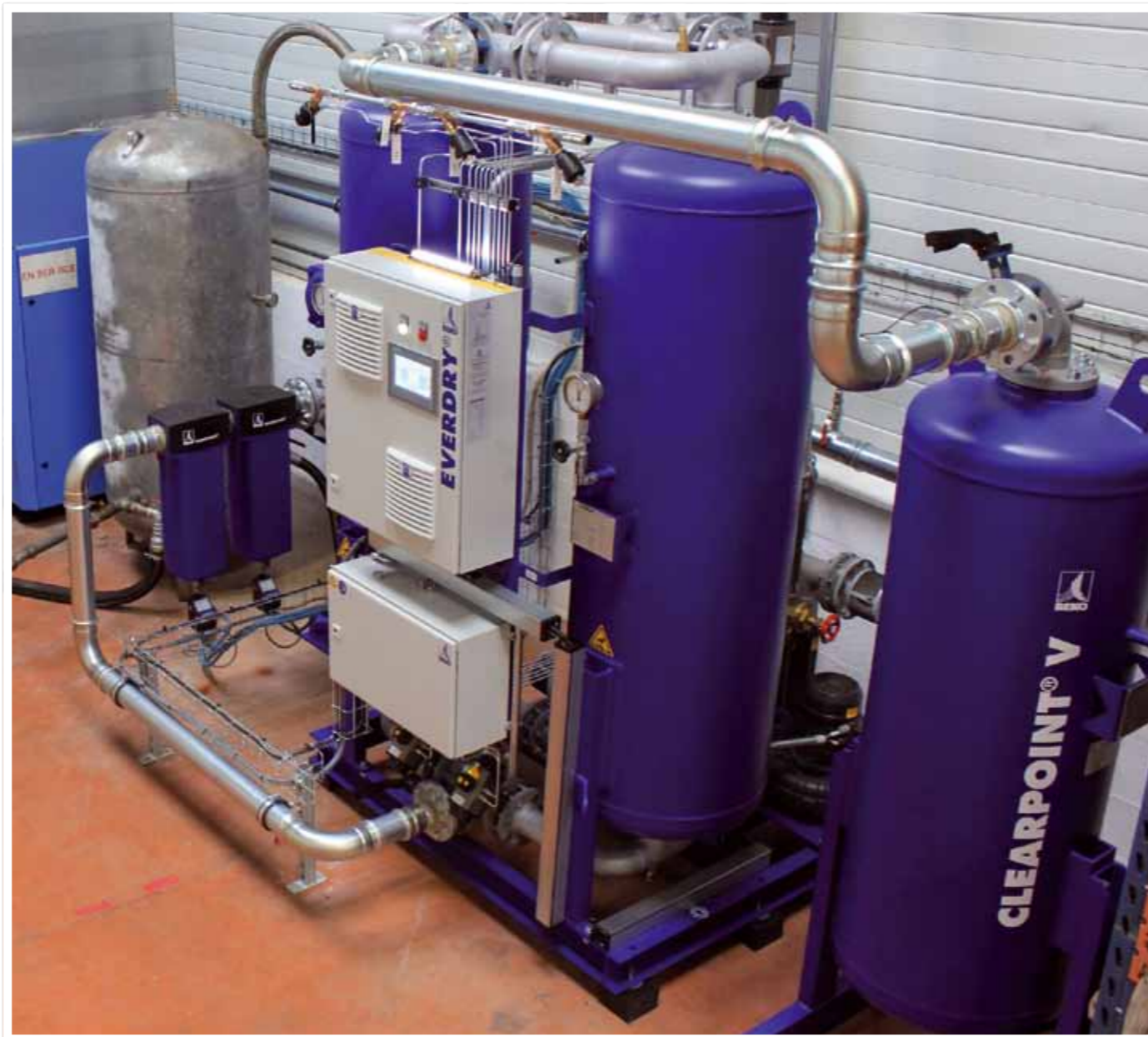
Le sécheur par adsorption EVERDRY® modèle FRA-VPlus « Zero Purge » et la colonne de charbon actif CLEARPOINT® VH constituent les pièces centrales du système de traitement d'air comprimé.
